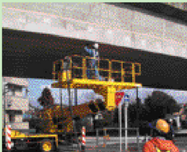
■ 高所天井部の研掃作業に
