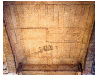
■ 天井部の作業に
