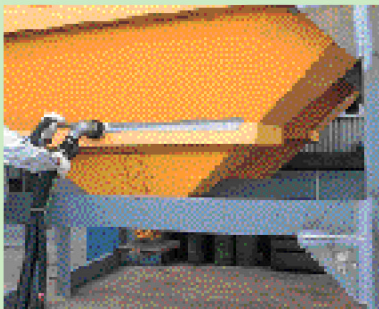
■ 溶接部の作業に
